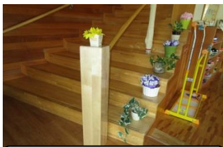
玄関前の手摺りの修理
