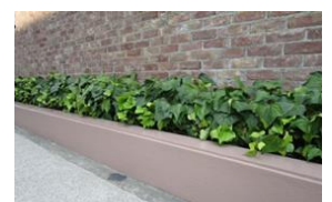
枠のひび割れの改修
